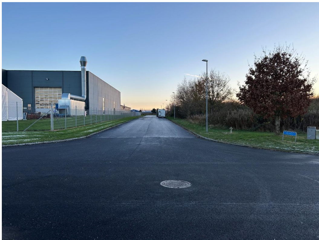
Figur 4 – Foto af planområdets nordøstlige afgrænsning i krydset mellem Limfjordsvej og Sallingsundvej.
