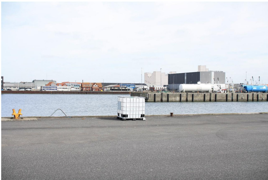
Figur 16 – Den nye bebyggelse er visualiseret med karréstrukturen centralt i billedet, mens hotelbygningen ses bag frysehuset til højre. Bebyggelsen er visualiseret som lys volumen uden materialer.
