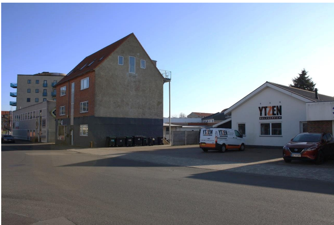
Figur 6 – Foto af eksisterende bebyggelse syd for Helgolandsgade, herunder bevaringsværdig bygning, set fra nordvest.
