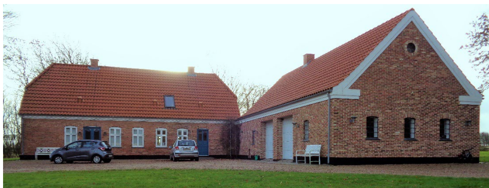
Billede 4. Eksempel på længehus: Husmandsstedet på Novrupvej 81, med stuehus i bedre byggeskik.
