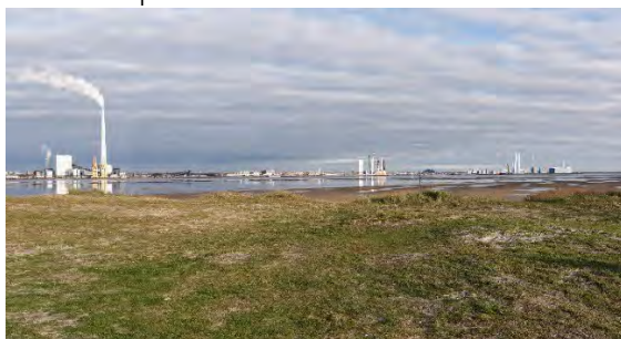
Udsigt mod Esbjerg Havn, fra Halen, Fanø. Fotostandpunkt 7.
