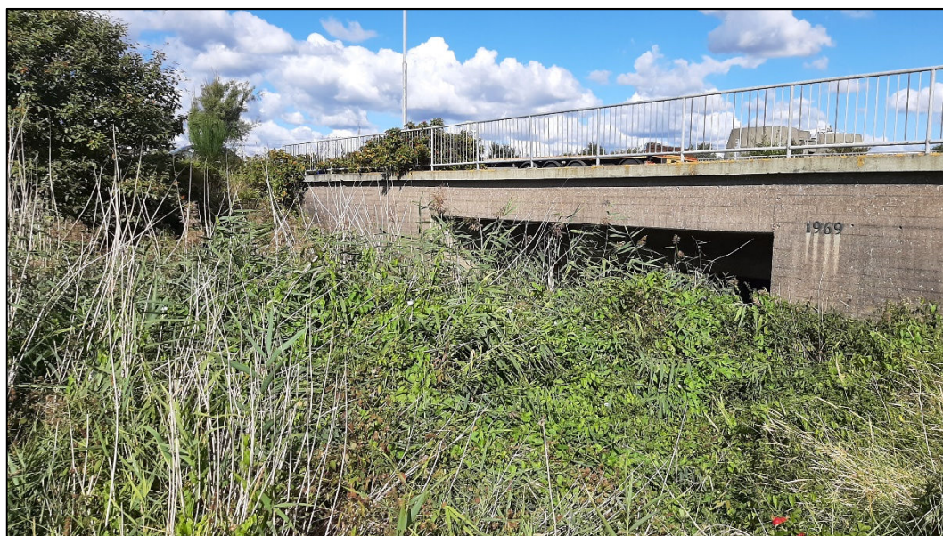
Figur 39 Broen over Mådevej hvorunder vandløbet løber fra nord til syd ind i undersøgelsesområdet.
