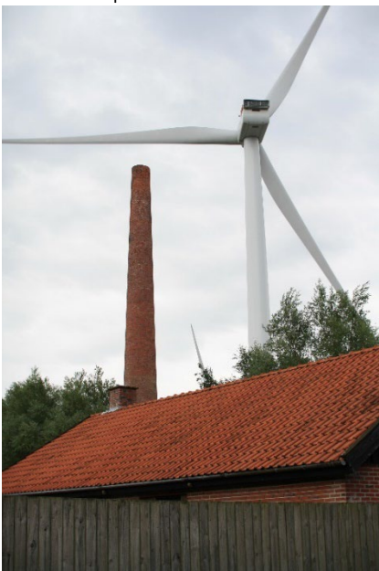
11. Gl. teglværksskorsten ved nr. 75 og vindmølle i planområdet.
