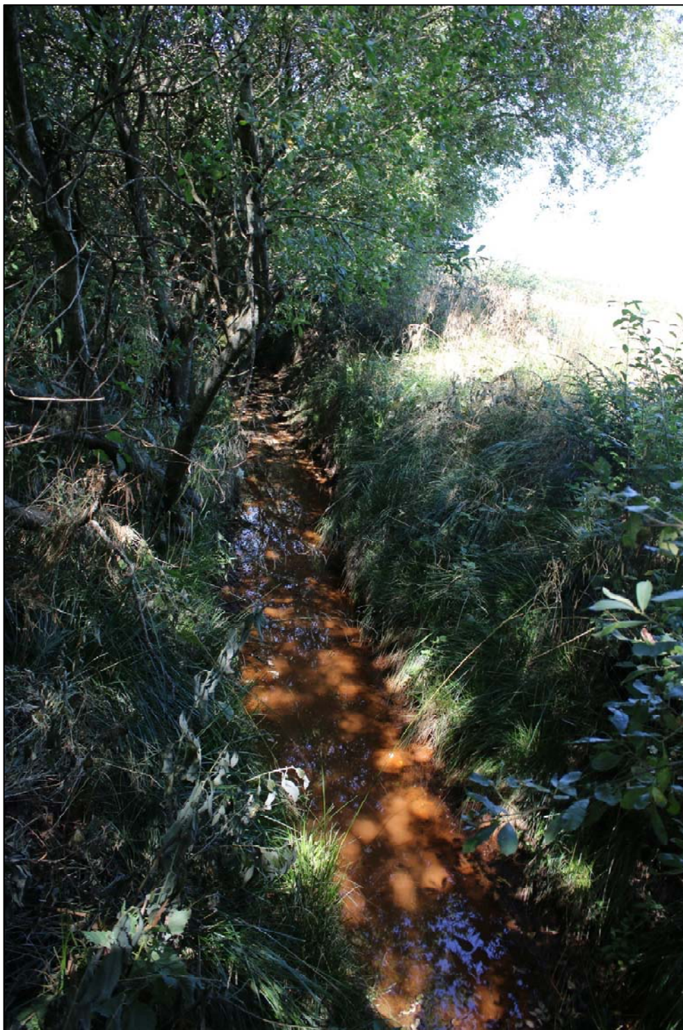
Figur 2-25 Vandløbet har lav vandstand og et relativt dybt dyndlag over fast bund.
