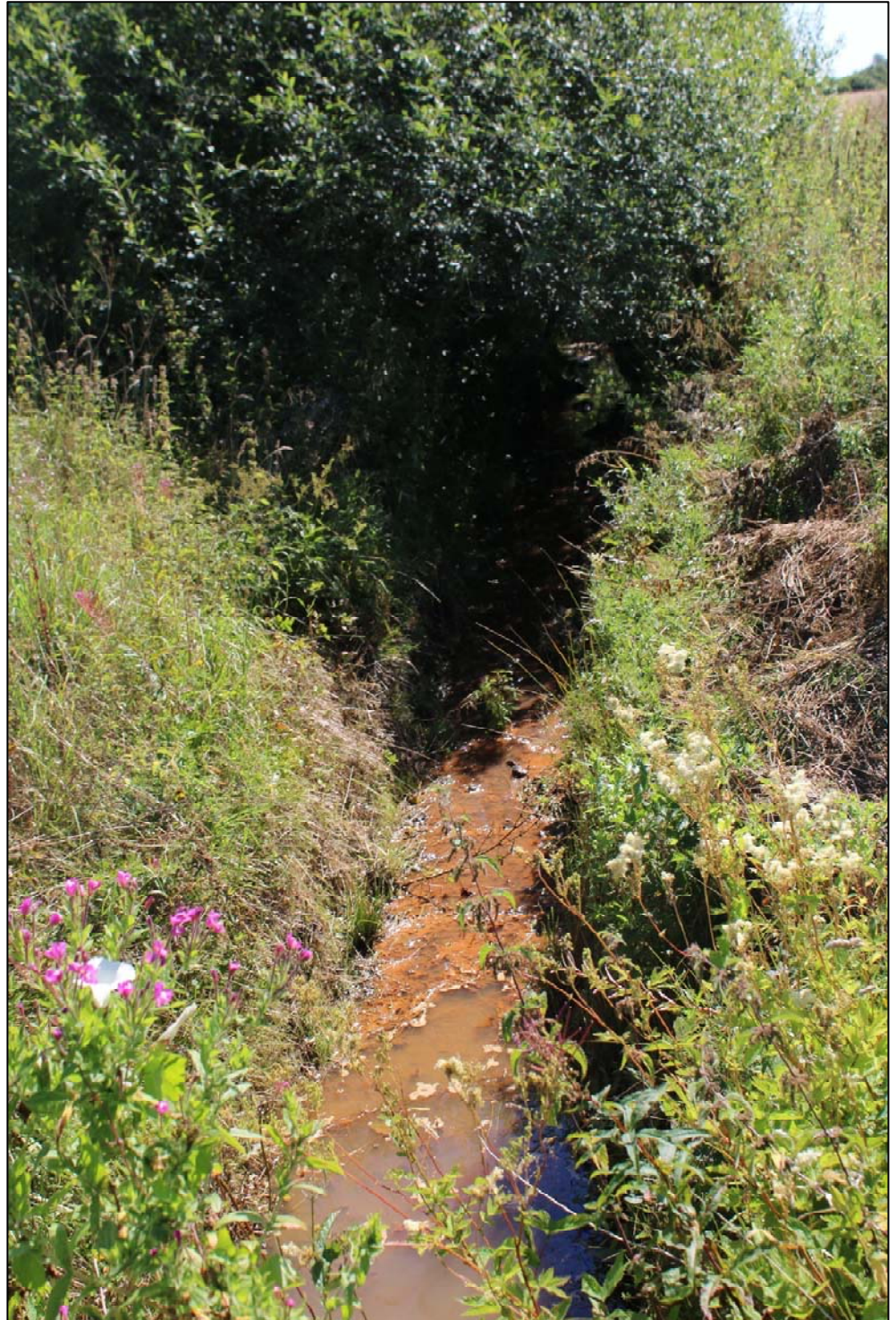
Figur 2-24 Vandløbet har karakter af en dyb og udrettet afvandingskanal med langsomt strømmende vand.
