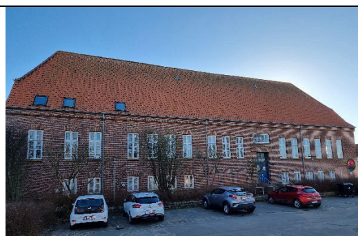
Bygningens nordvendte facade før ombygning set fra nordøst.
