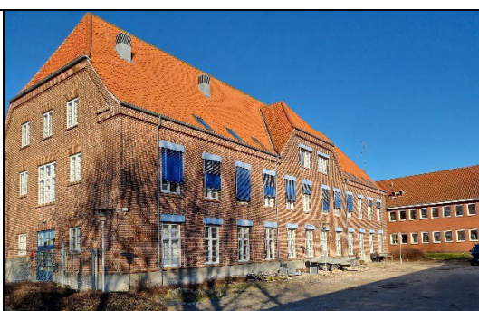
Bygningens sydvendte facade før ombygning set fra sydvest.
