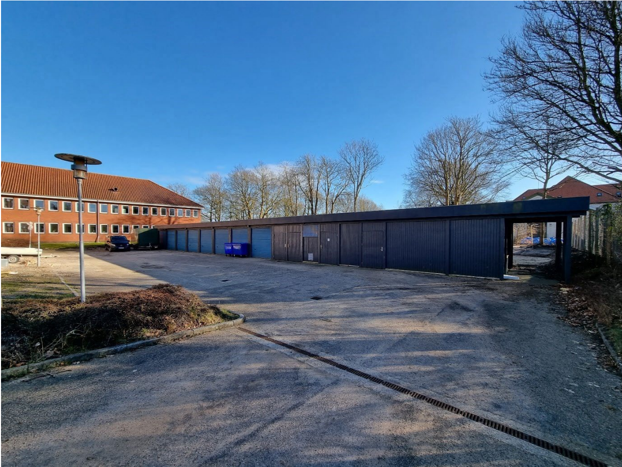
Garageanlægget syd for den bevaringsværdige bygning. Dele af anlægget forudsættes revet ned.
