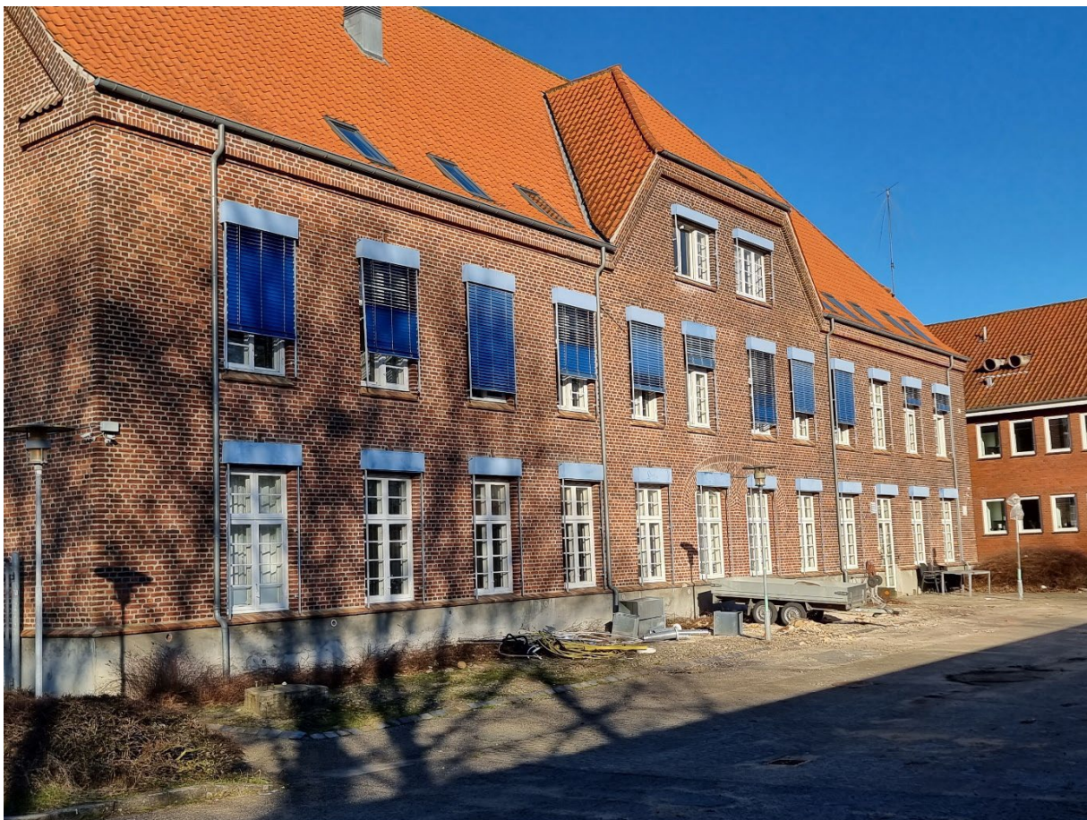
Bygningens sydfacade med solafskærmningen trukket for, tagvinduer samt tilmuret vindfang.
