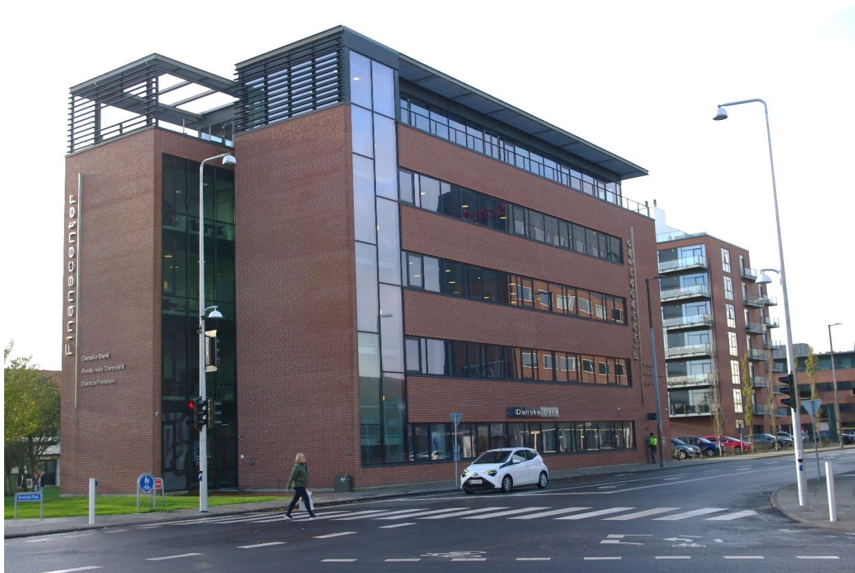
Figur 5 - Eksisterende kontorbebyggelse i området set fra Strandbygade.
