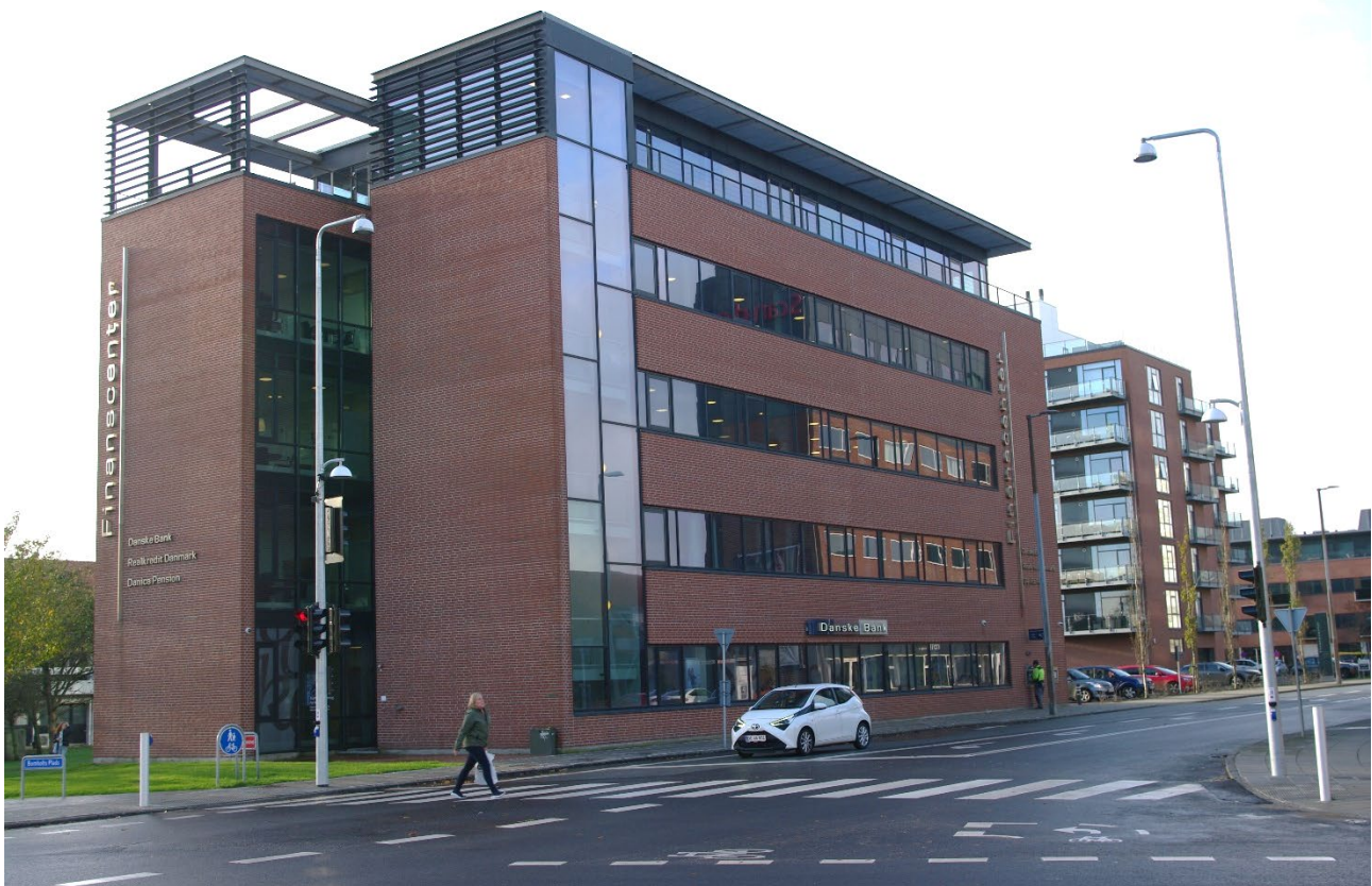
Figur 3 - Eksisterende kontorbebyggelse i området set fra Strandbygade.
