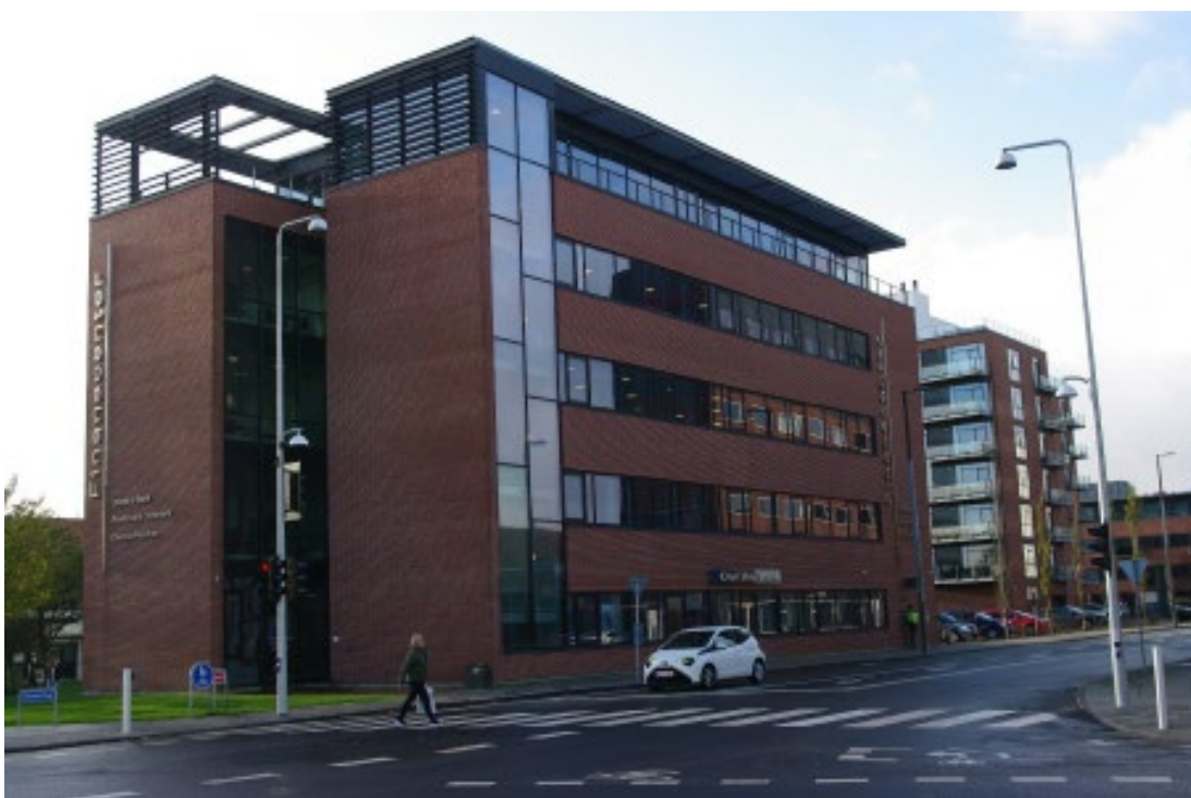
Figur 25 – Billedet viser eksisterende bebyggelse inden for delområde B.
