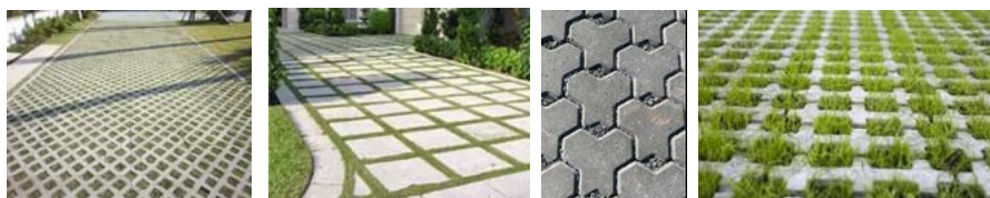
Eksempler på belægninger med porøse fuger, der tillader nedslivning af regnvand.
