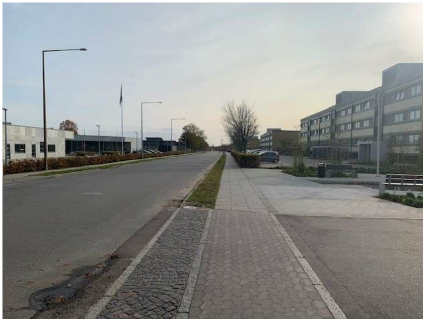
Set fra Stengårdsvej mod syd: Den renoverede almene boligbebyggelse langs Stengårdvej ses i billedets højre side. I venstre side ses det nye bydelshus som blandt andet rummer en aldersintegreret institution.
