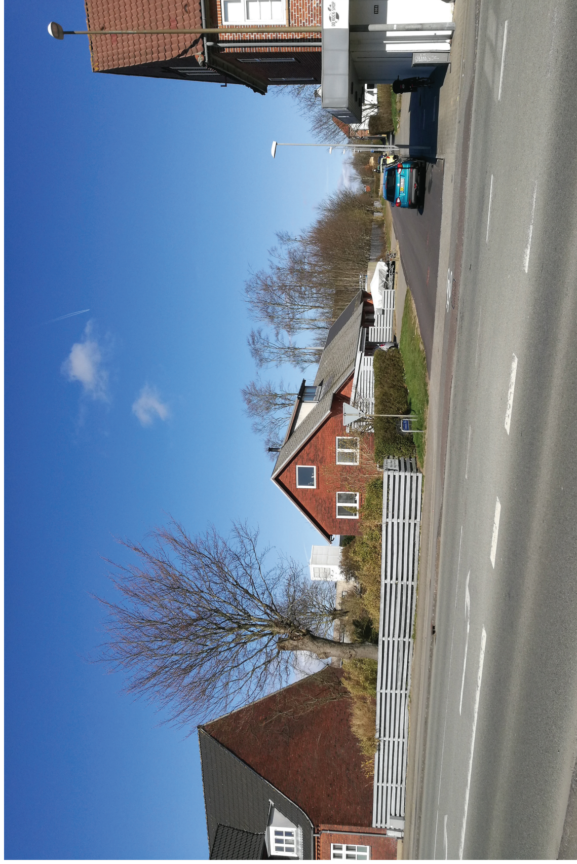
Fotostandpunkt 2 Eksisterende forhold
