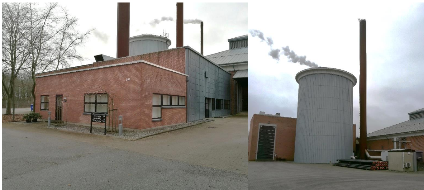
Figur 2: De eksisterende bygninger i lokalplanområdet.
