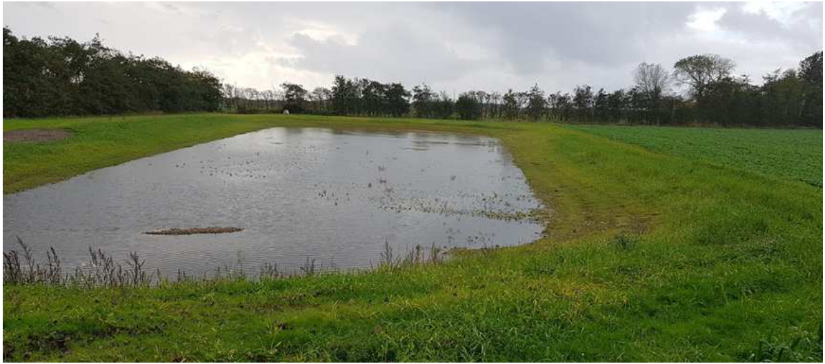
Figur 6 Det nye regnvandsbassin umiddelbart øst for det vestlige delområde, set fra nord.
