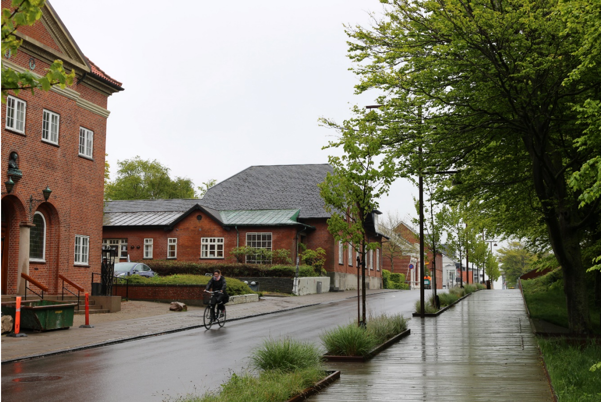
Punkt 4 Eksisterende forhold set fra Havnegade ved Vandtårnet.
