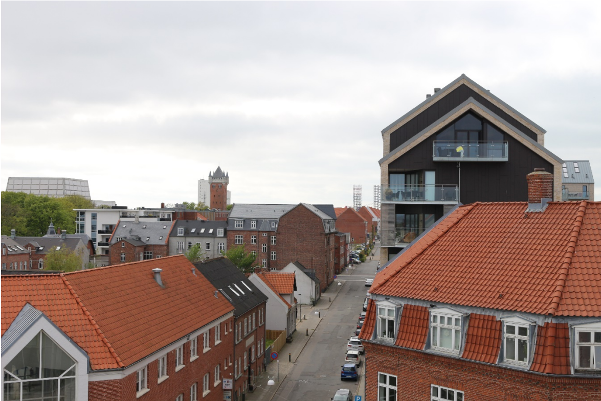
Punkt 6 Eksisterende forhold set fra Broens parkeringsdæk mod Borgergade.
