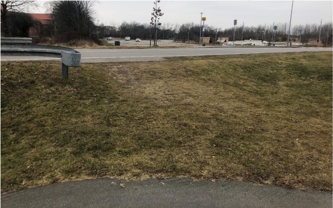
Figur 7. Trampesti fra stibroen mod busstoppestedet og stien ved parkeringspladsen på vestsiden af Sportsvej.
